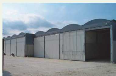
Κλειστό σύστημα κομποστοποίησης σε σειράδια με εξαναγκασμένο αερισμό και μηχανική ανάδευση. Τα βιοαπόβλητα τοποθετούνται μέσα σε οριζόντια κανάλια.
